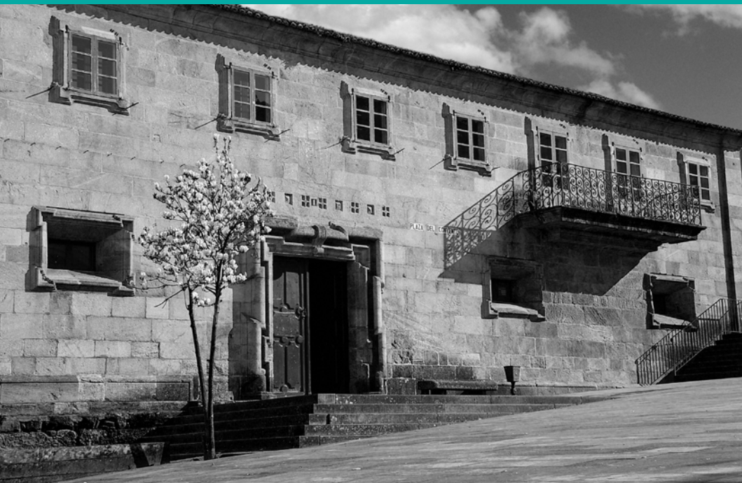
FACHADA PRINCIPAL CONVENTO DOS AGOSTIÑOS
