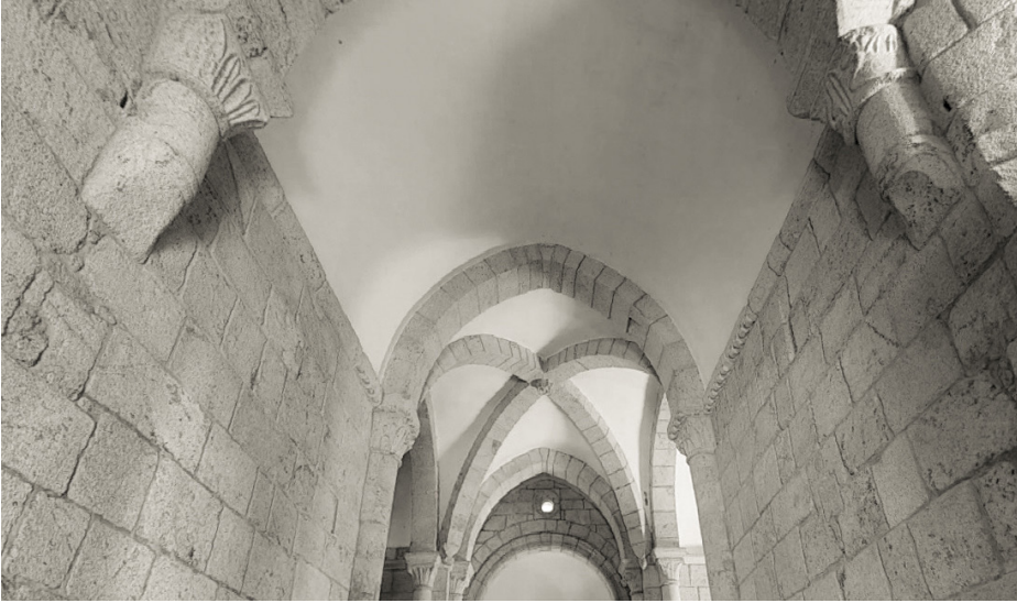
Fig. 6: Bóveda cuatripartita do cruceiro, e de medio canón na nave principal 11 .
